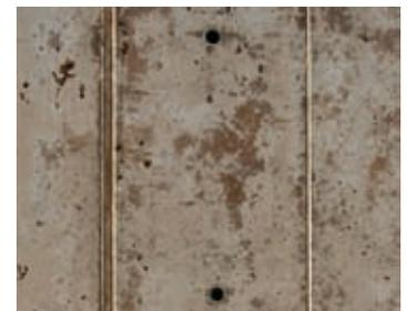
图28 沙尔克研究中心禅缝
