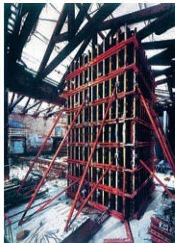
图1 威尼斯海关大楼清水混凝土模板系统
