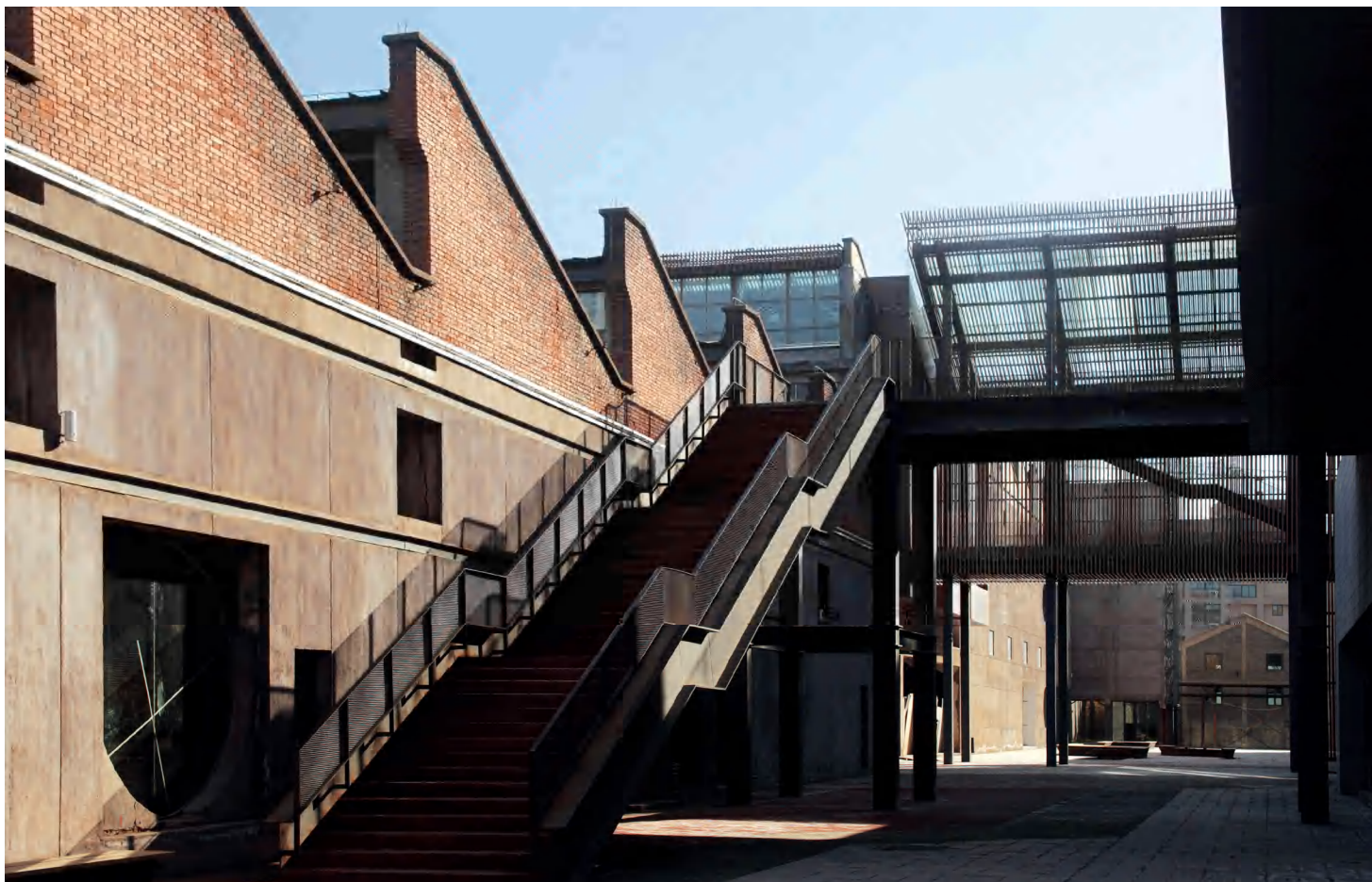
图17 改造中增加的楼梯、连桥等立体交通元素
