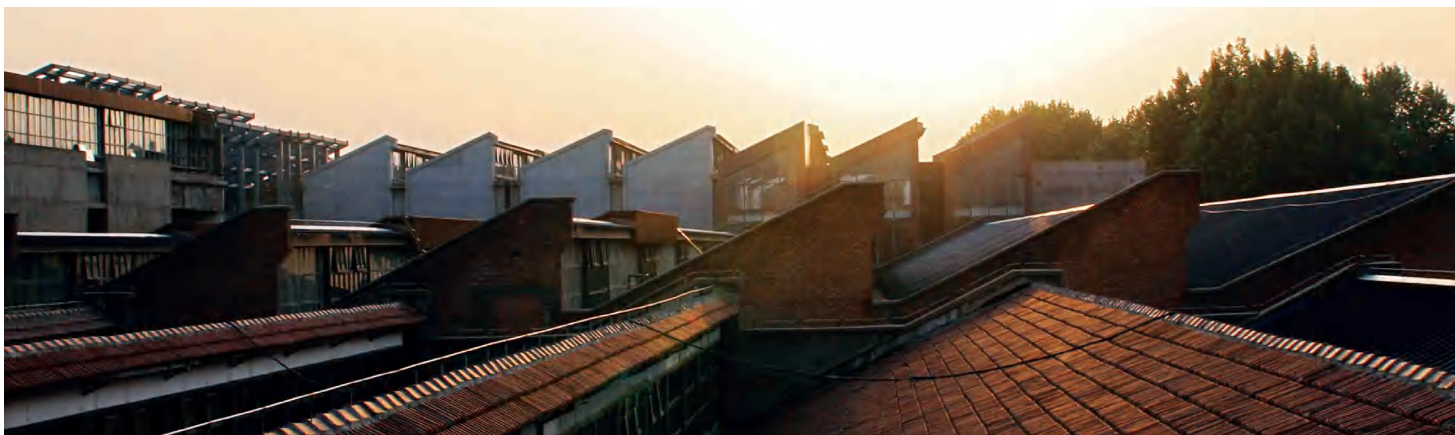
图16 通过改造得以延续并强化的建筑屋面轮廓线
