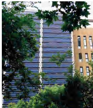
图8 东立面太阳能板
