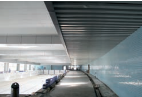
游泳训练馆现场
