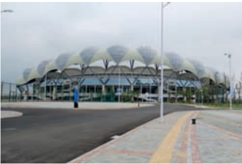
综合性体育场外景
