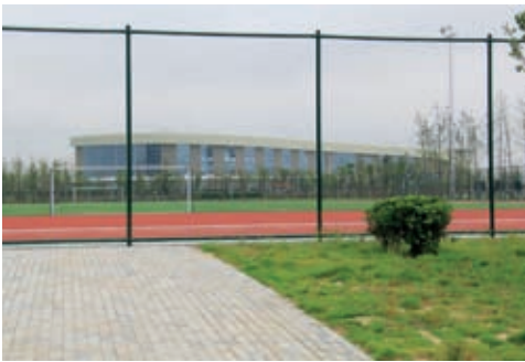
综合性体育馆外景
