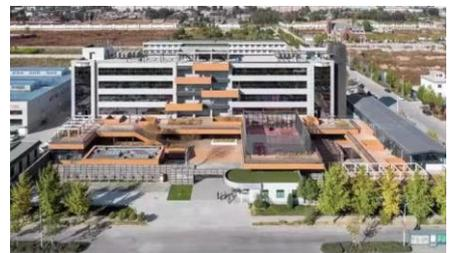
建设。项目建筑面积共 12 200 m<sup>2</sup>，采用少拆除、多利用、快建造、低投入、高活力、可再生的总体原则，以微介入的方式打造城市更新中既有改造的示范案例。倡导绿色行为模式、装配模块化建造、被动低能耗、废旧材料利用、海绵花园、可再生能源循环、城市屋顶农业、零碳展示办公等多种生态绿色理念。同时利用生长的概念创造共享的活力社区和交流空间，用现代手法延续中国传统院落空间和集群组合的意念，最终形成设计之都的文化园区。
