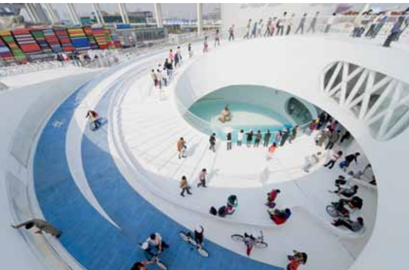
螺旋坡道上升台建筑顶部（摄影：Iwan Boan）
