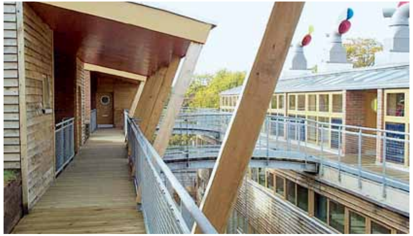
护栏的部分材料来自回收再利用的工地的脚手架。
