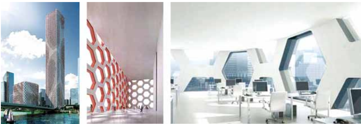
图10 中钢大厦外观、内部空间
