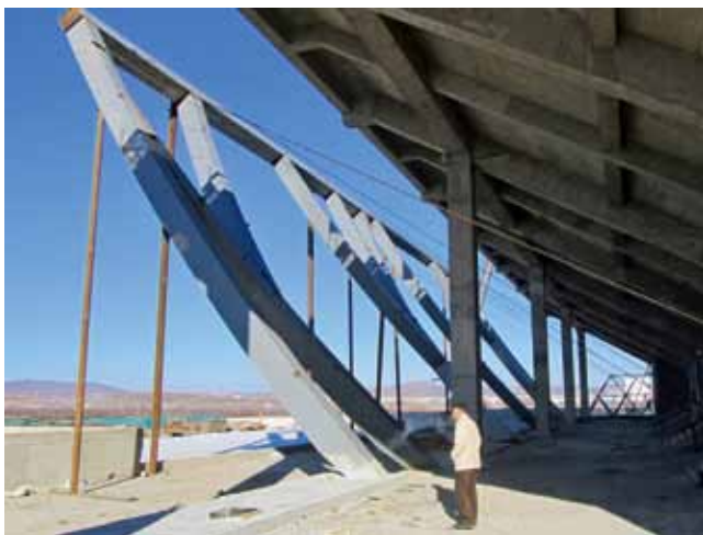
门厅部分钢结构施工
