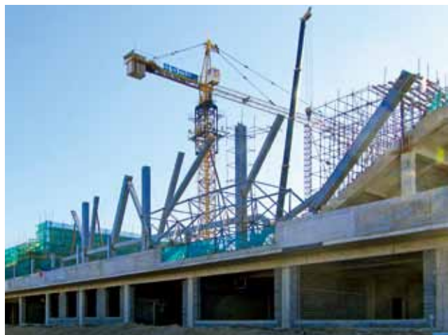
立面钢结构施工
