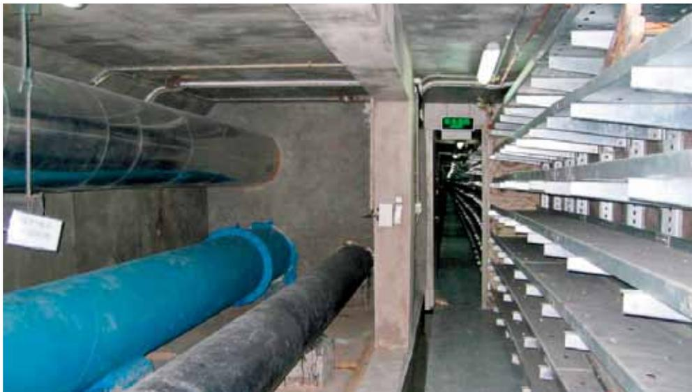
图19 中关村西区管廊照片
