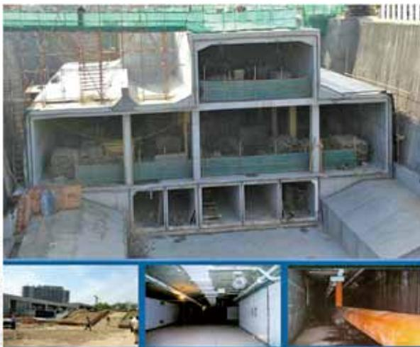
图8 中关村西区管廊+地下交通环隧一体化设计
