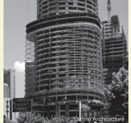
用核心筒与巨柱系统，该系统在金茂大厦、台北 101 和深圳平安大厦也得以应用。在核心筒与巨柱之间需要设置一个加强联系结构——伸臂桁架，就像是一根根桅杆或横撑一样将巨柱和核心筒联系在一起。伸臂桁架一般设置在避难层。
