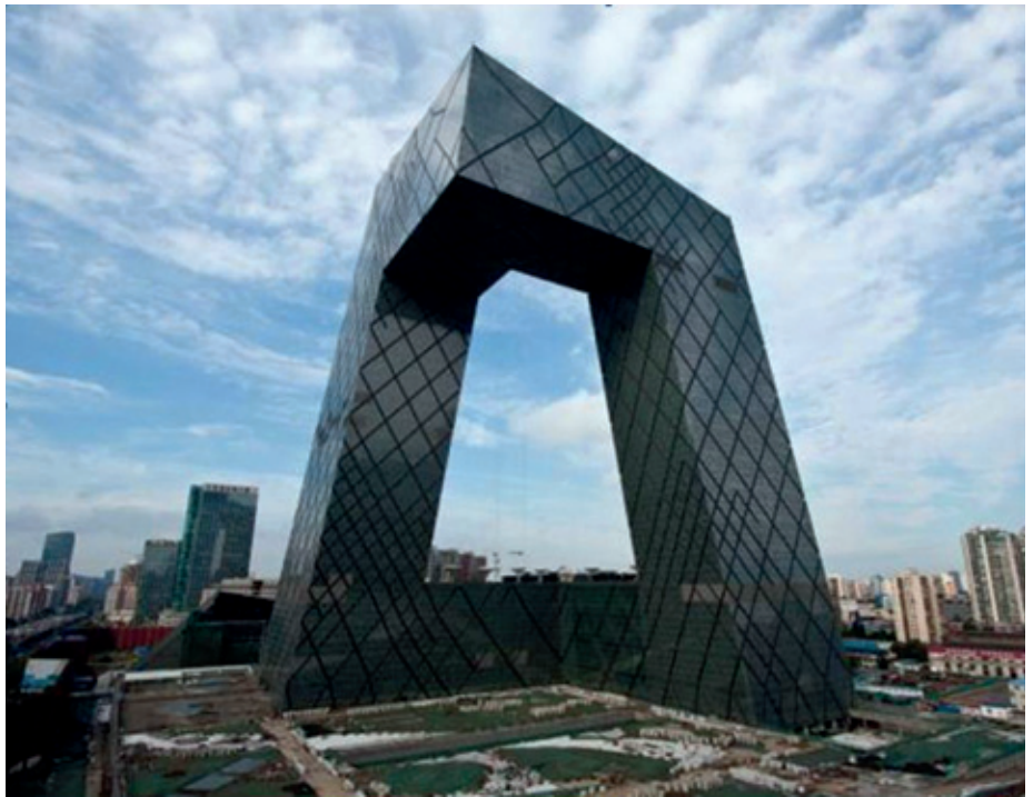
图16 竣工后的建筑
