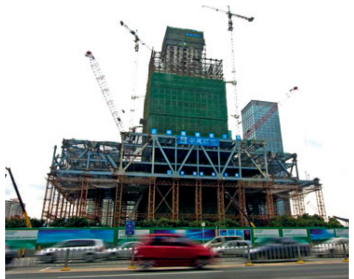
图24 施工中的裙楼(临时支撑已移除)
