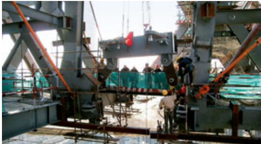
图15 第一件连接构件的安装
