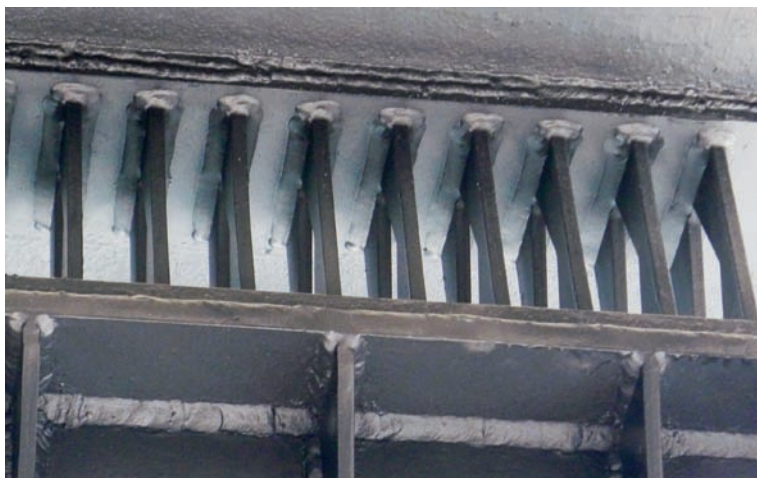
消能减震支撑
