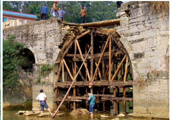
太平古桥修复建造过程
