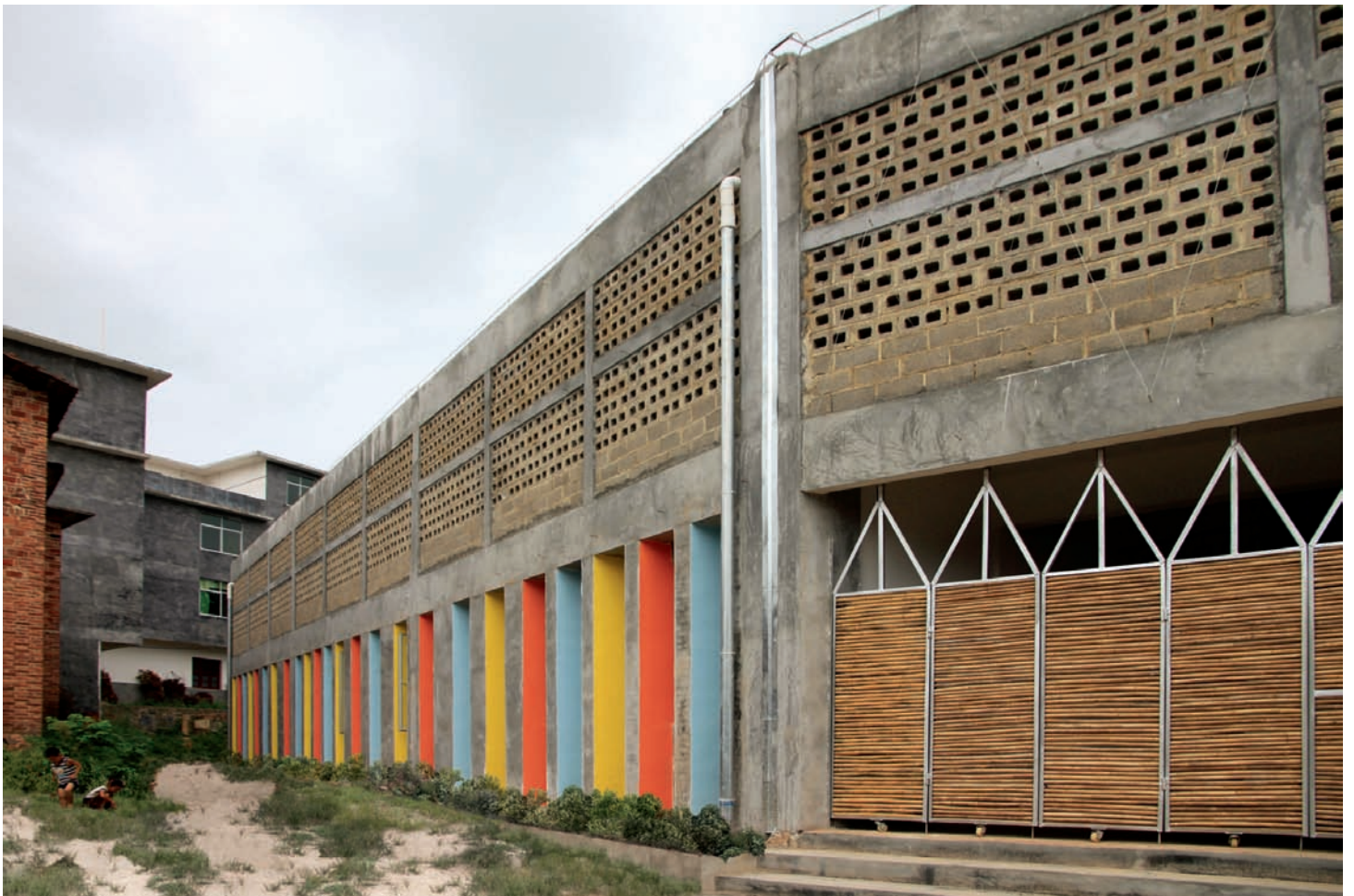
丰富的建筑立面
