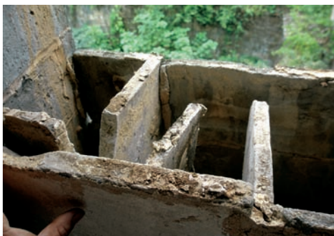
图2 空斗墙断面照片
