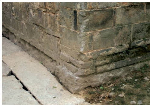
图1 空斗墙下面青砖实砌
