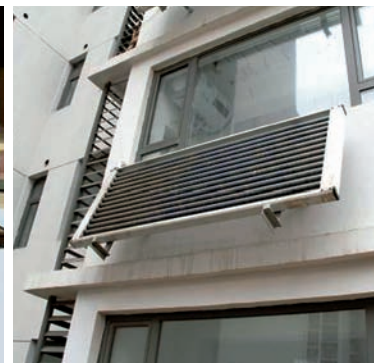
图17 集热器固定在阳台栏板上
