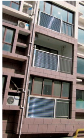
图20 集热器与栏杆、平台一体化
