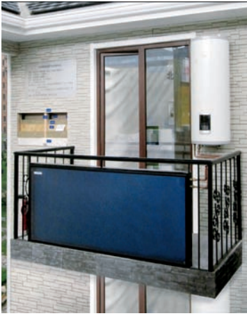
图19 集热器作为栏杆构件
