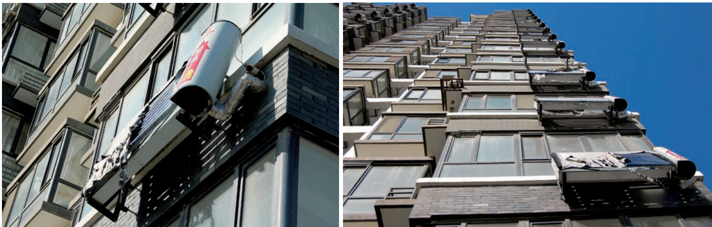
图18 高层太阳能与水箱一体安装在阳台栏板上
