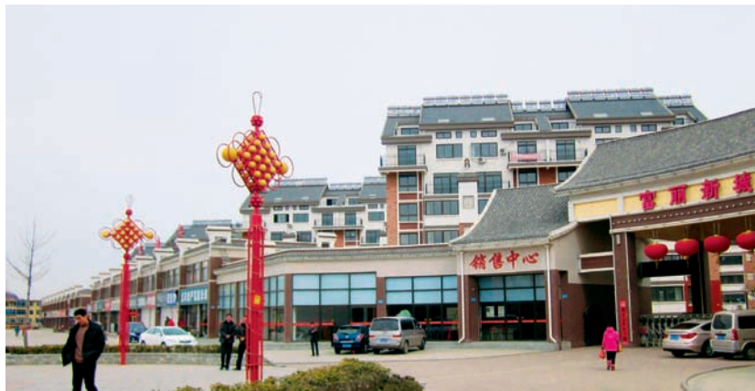
图1 烟台福山某多层小区屋顶直插式太阳能热水器整体造型与建筑和谐一体,美观经济
