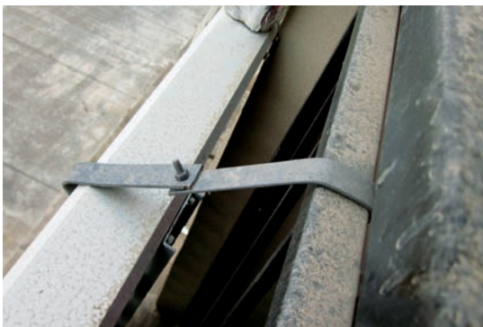
图15 集热器固定在栏杆上
