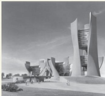
卡塔尔石油综合体：SOM设计。建筑群由一系列自由生长的叶片状混凝土柱支撑，这与严酷的沙漠气候以及中东地区的自然景观特征相适应。
