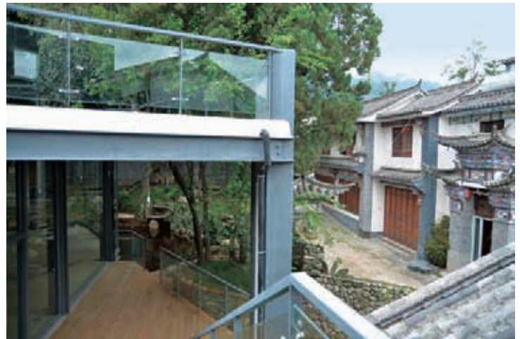
建成实景照片
