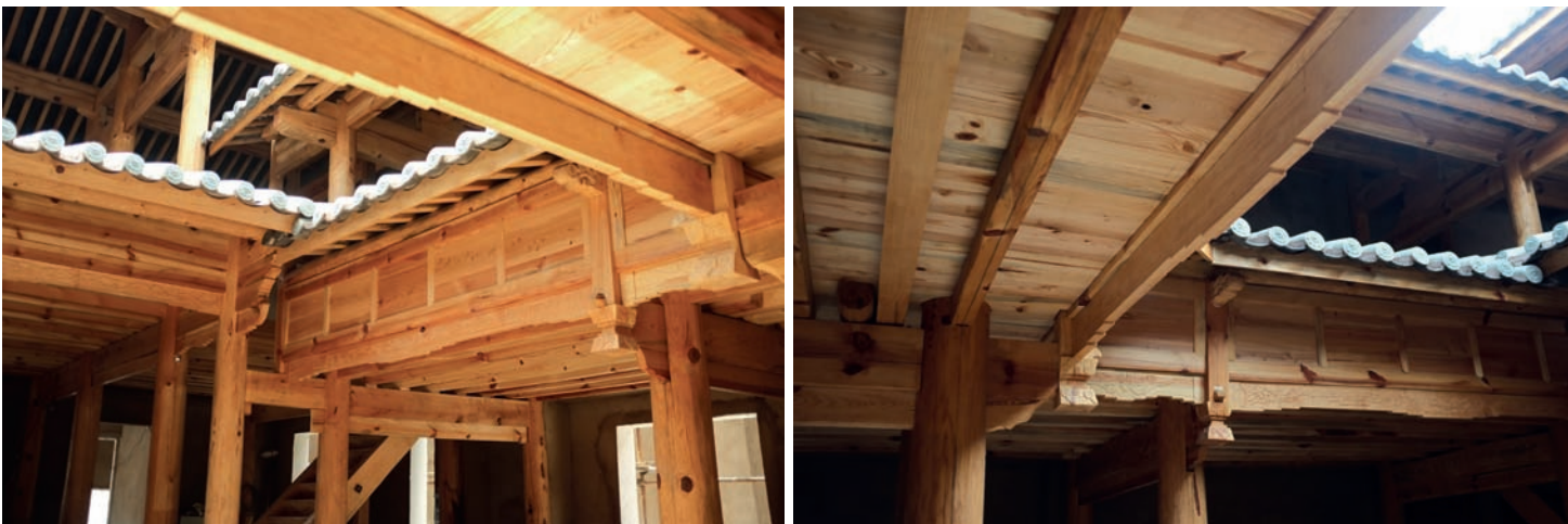
大木作工地现场
