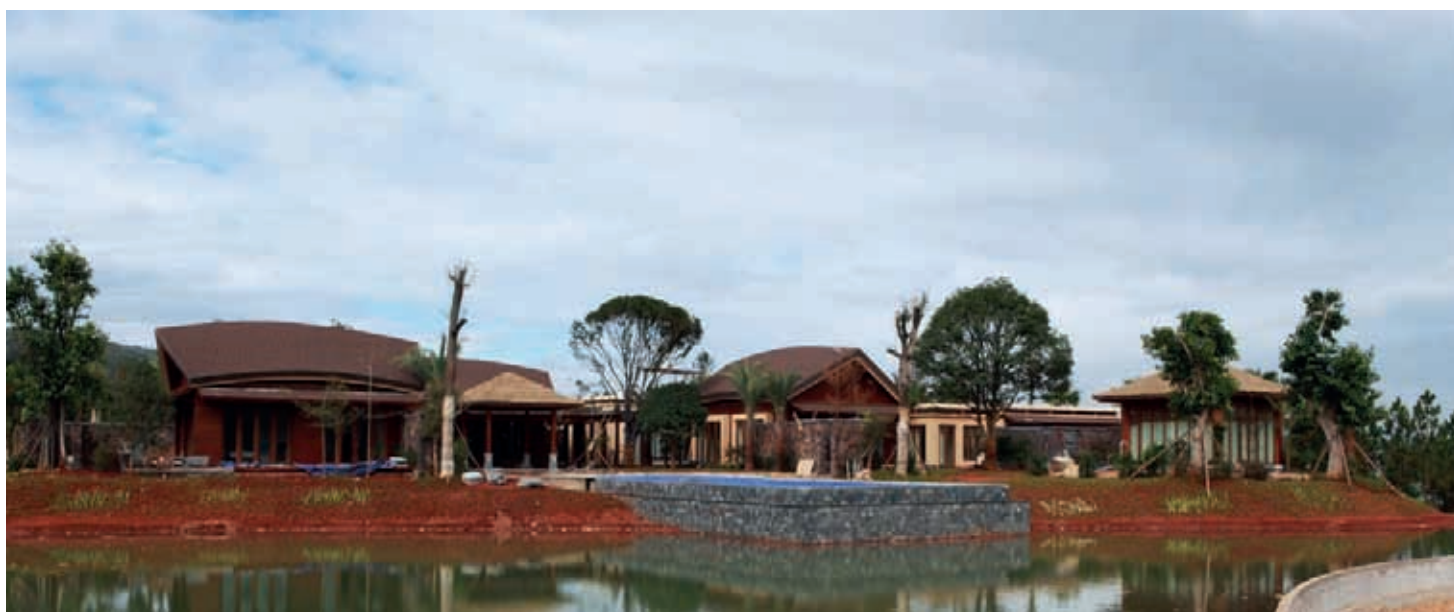
施工中的VIP汤院东南向外观
